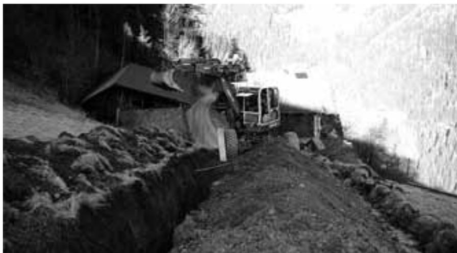
Nachdem es wieder wärmer wurde, konnte in Onach mit den Arbeiten zur Erneuerung der 35 Jahre alten Trinkwasserleitung begonnen werden. Da auf der bestehenden Leitung immer häufiger Probleme aufgetreten sind, können die Onacher nun zukünftig wieder auf eine sichere Wasserversorgung zählen. Die Bauarbeiten werden von der Firma Huber und Feichter durchgeführt und sollen innerhalb Mai abgeschlossen werden.
